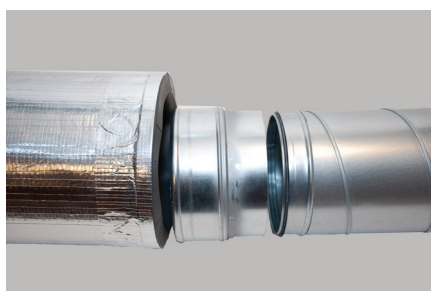
CR övergång + plåtnippel + plåtkanal
